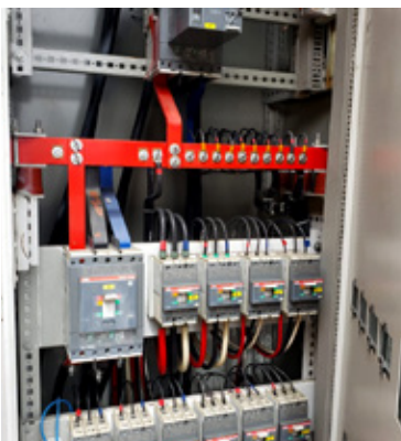
Reparación de sistema de transferencia automática (IPSOS PERU)
