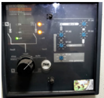
Reparación de sistema de transferencia automática (Apoyo Consultoría)
