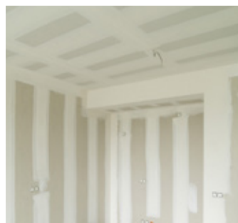
Instalación de Drywall y pintura en general
